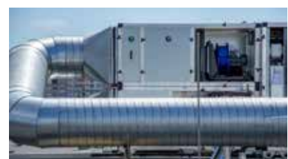
Ambientes residenciales y comerciales
